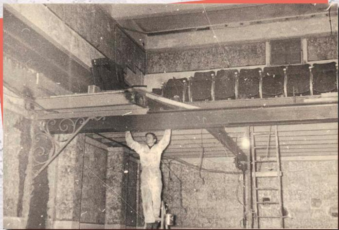
La cabine est modernisée, c'est l'apparition du **cinémascope**, qui permet une image panoramique. L'écran est agrandi. Les appareils fonctionnent avec des électrodes en charbon. La projection de **films en 35 mm** oblige l'opérateur à changer d'appareil à la fin de chaque bobine. Suivant sa longueur, une copie représente **8 à 12 bobines**.
