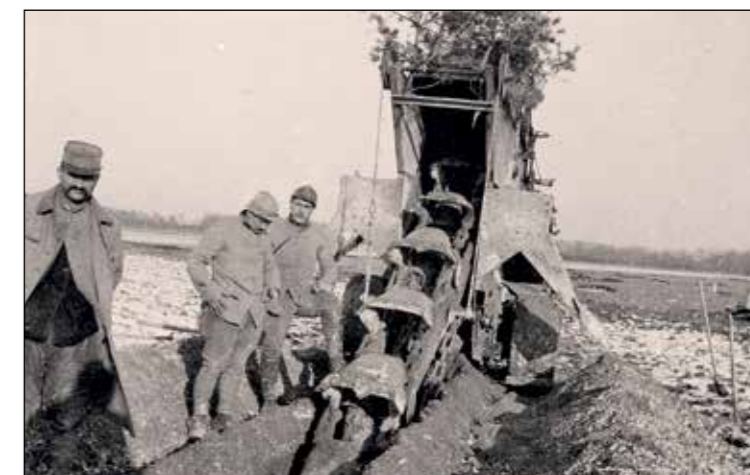
Tous les boyaux et tranchées n'ont pas été creusés à la main. Quelquefois les machines ont bien aidé les hommes. Quelques branches d'arbre déposées sur la machine font office de camouflage.
