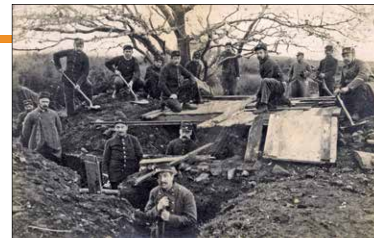
Des soldats du 14 ème régiment d'infanterie creusent une tranchée.
