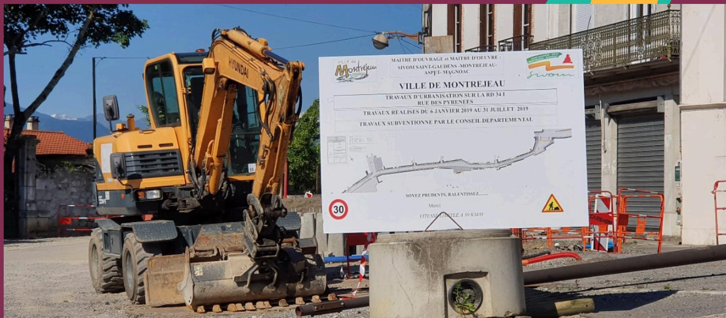
Il s'agit d'un réaménagement de la rue des Pyrénées qui comprendra l'effacement des réseaux aériens (électricité, téléphone) d'une mise aux normes du réseau d'eau potable (changement des branchements en plomb en PE) d'un ancien réseau d'adduction. Ces travaux comprendront aussi une vérification et/ou une installation de boîtes de branchements des eaux usées au tout-à-l'égout. Les personnes concernées raccorderont leur canalisation privée aux boîtes de branchements.
