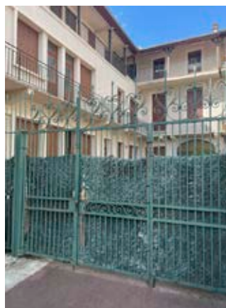
Rénovation de l'appartement de l'ancienne perception (peintures, toile de verre) au profit des médecins du centre municipal de santé réalisée en régie.
