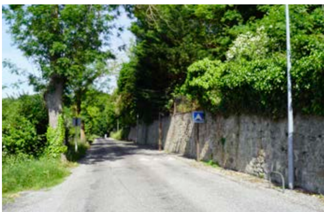
Réfection de la voirie chemin de Capel, rue Adoue et rue Alquie réalisé par le SIVOM.
