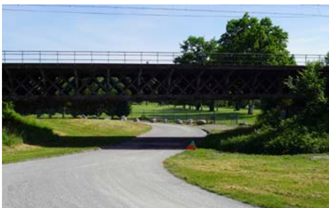
Restauration de la voirie après inondation de la base de loisirs réalisé par le SIVOM.
