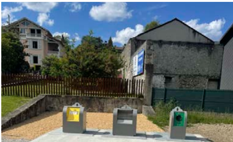
Mise en place de points d'apports volontaires enterrés par le SIVOM, au rond-point du Lidl, rue de la Font du Bourg et place de l'Orme.
