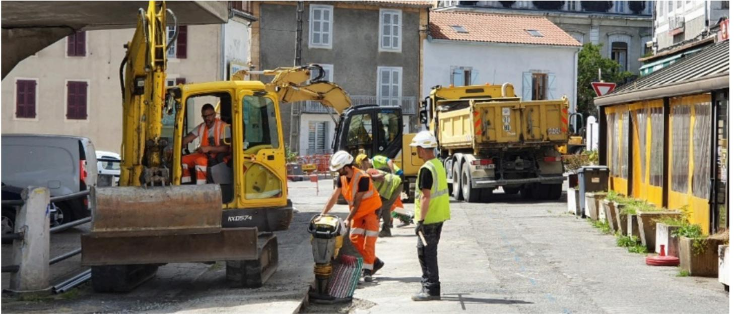
La mise en place du réseau de la fibre comprendra des travaux d'excavation et de pose d'armoires à partir de chambres télécom existantes. Les travaux devraient s'achever au mois d'octobre pour une mise en service en fin d'année.
