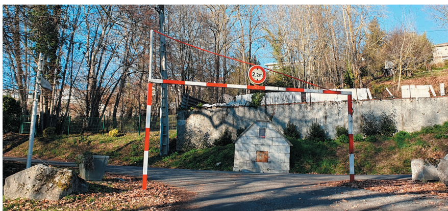
Remise en état d'un portique de limitation de hauteur rue Paul Adoue (accès au golf).
