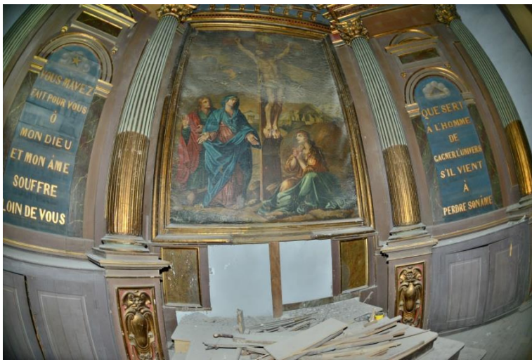
Derrière l'orgue dépôt de gravats
