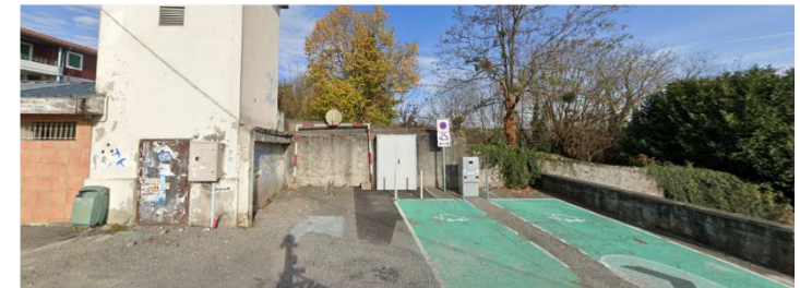
Ouverture du mur depuis le Place de Verdun
